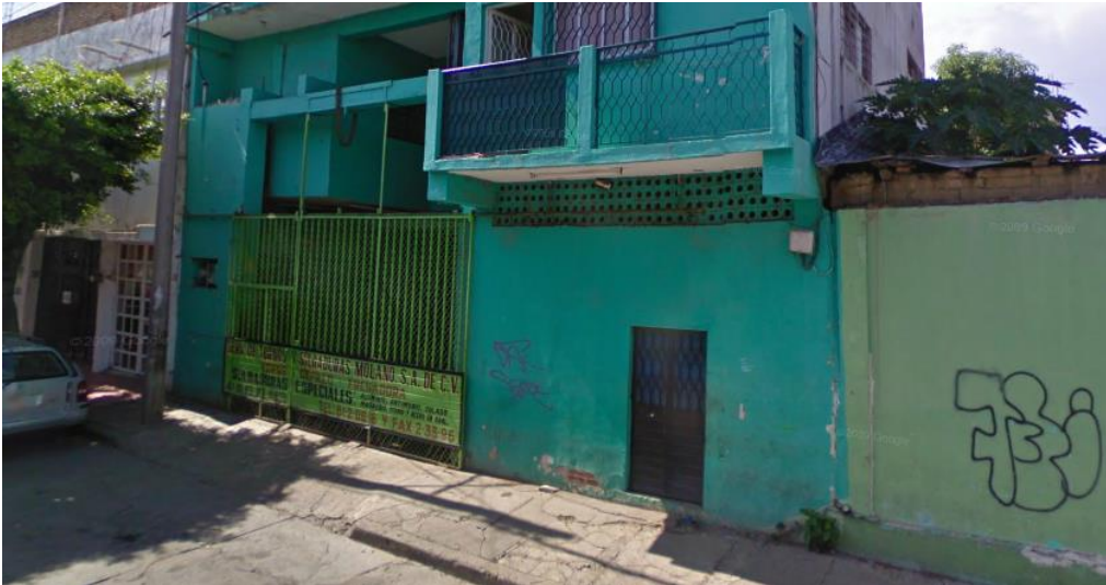
Figura 2.1 Micro Localización del Taller de Servicio de Torno y Soldadura Molano S.A De C.V
