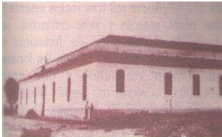
Figura 2.2 Primer hospital de Tuxtla.
