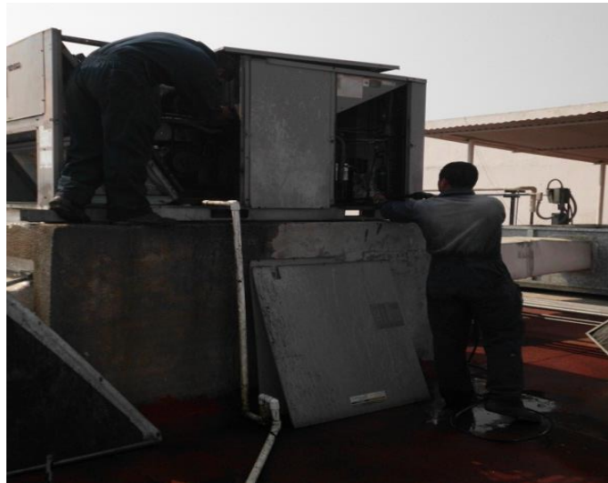
Aire acondicionado tipo paquete.
