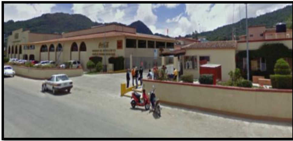
Fig. 2.2 inmuebles del golfo planta san Cristóbal (Fachada) [Fuente: Google mapas]
