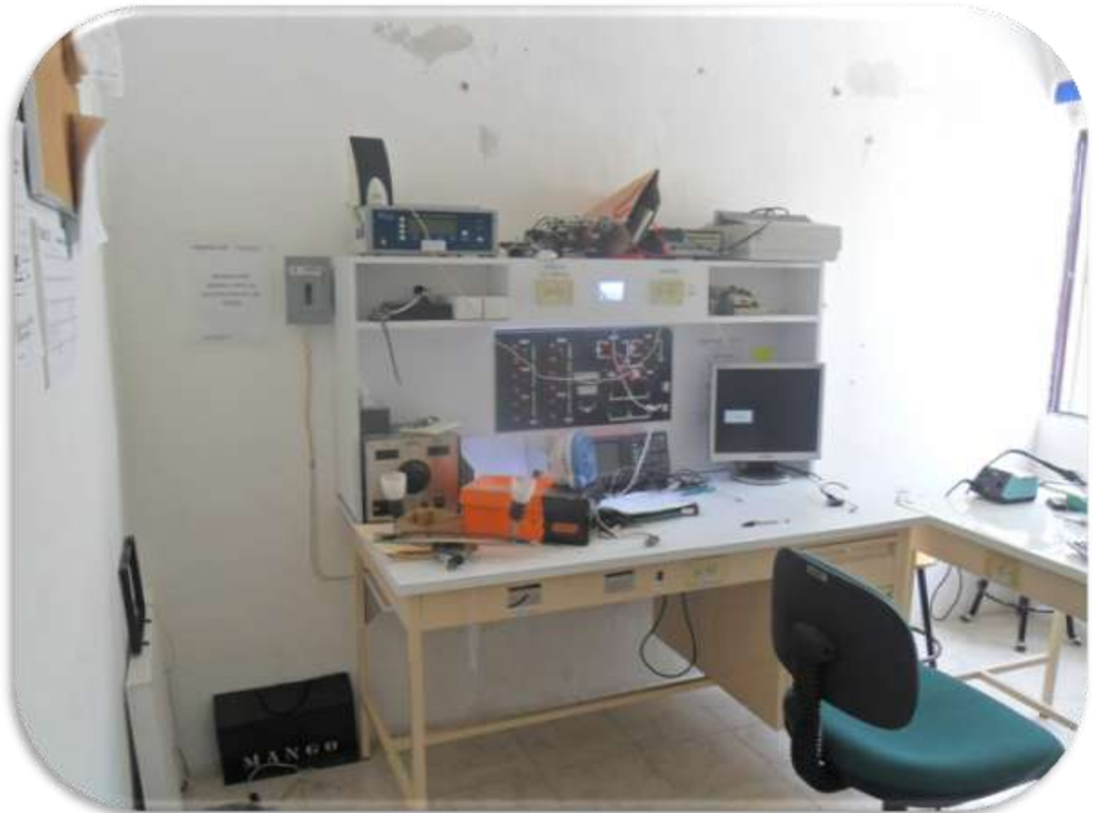
Figura 2.6 Tablero de Control (Fuente: información recabada).
