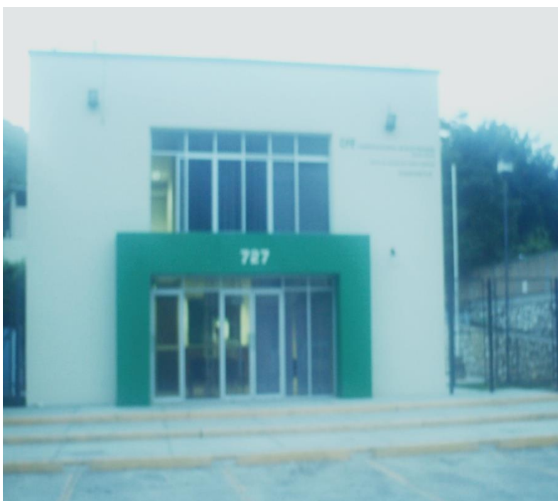
Figura 2.3 Edificio Principal de la Agencia Comercial Ocozocoautla (ACO)
