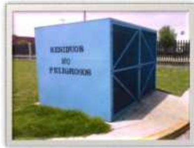
FIGURA 5.16 ZONA DE RESIDUOS NO PELIGROSOS (FUENTE: INVESTIGACIÓN PROPIA).
