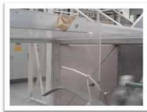
FIGURA 5.7. ESTRUCTURAS TEMPORALES (FUENTE: INVESTIGACIÓN PROPIA)
