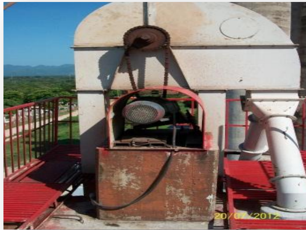
Figura 5.14 Restauración de maquinaria e infraestructura expuesta. (Fuente: Elaboración Propia).
