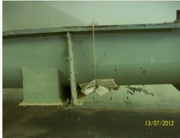
Figura 5.15 Reparación de equipos. (Fuente: Elaboración Propia).
