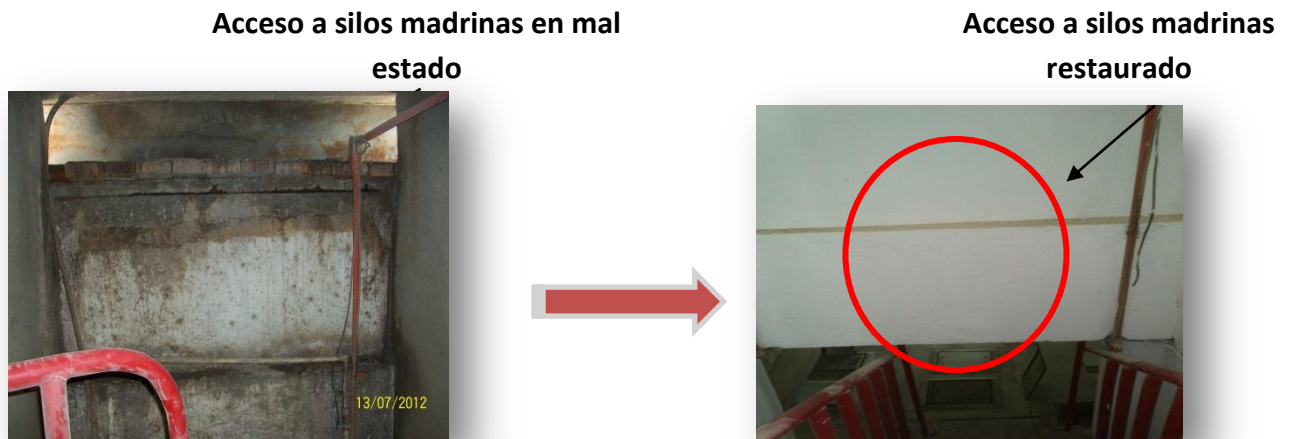
Figura 5.8 Restauración de infraestructura dentro del área de almacenamiento. (Fuente: Elaboración Propia).
