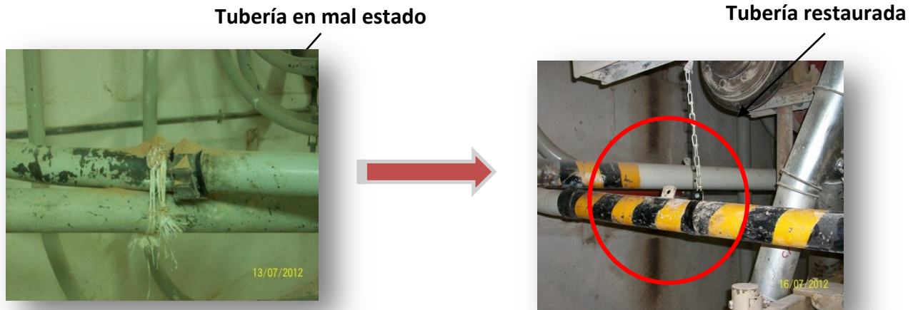
Figura 5.7 Colocación de colgantes a tuberías de producto. (Fuente: Elaboración Propia).
