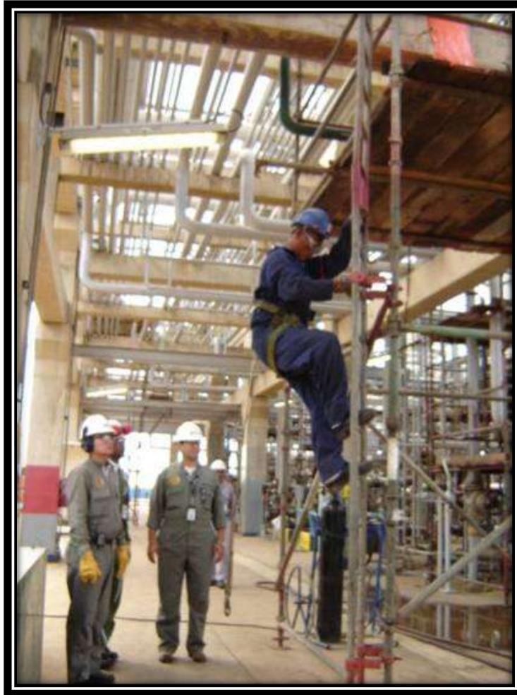
Figura 7.3 Trabajos en altura
