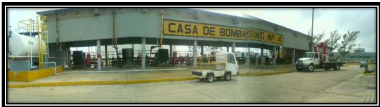
Figura 7.2. Casa de Bombas 4
