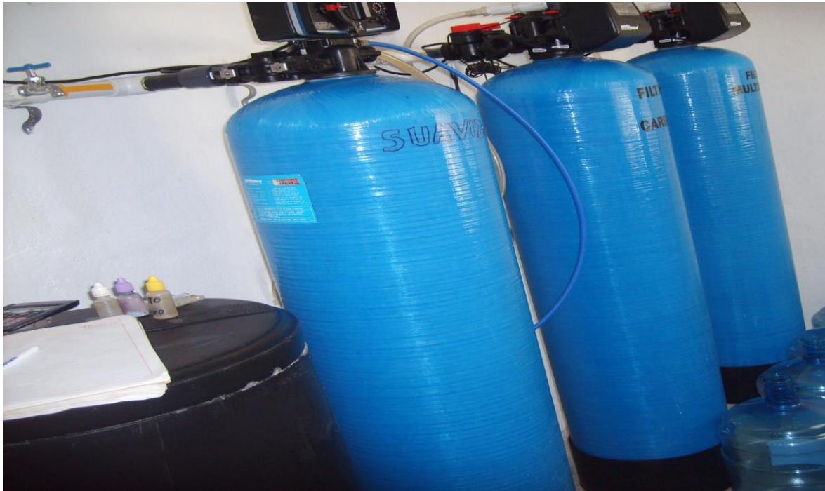
Foto 2-3 Área de filtros
