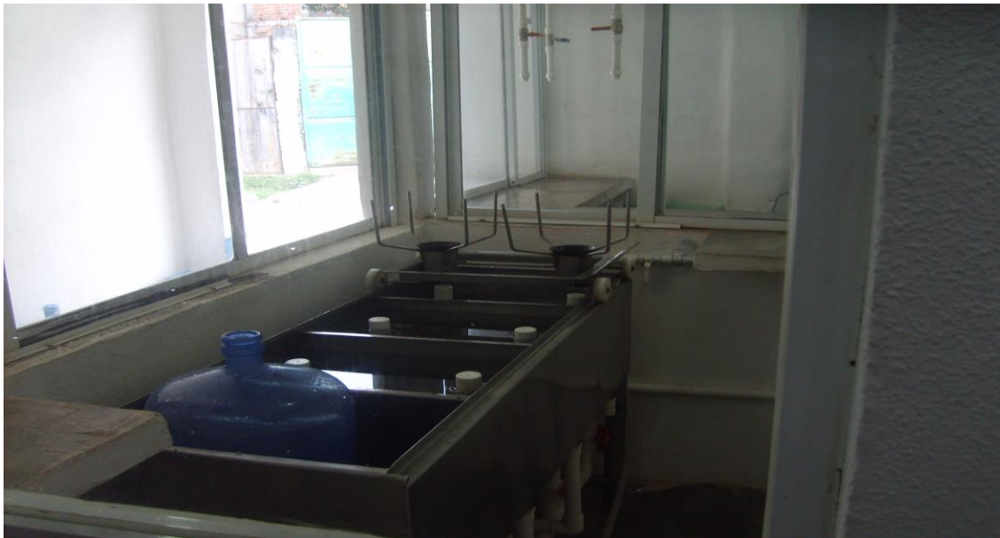
Foto 2-1 Área de lavado de garrafones
