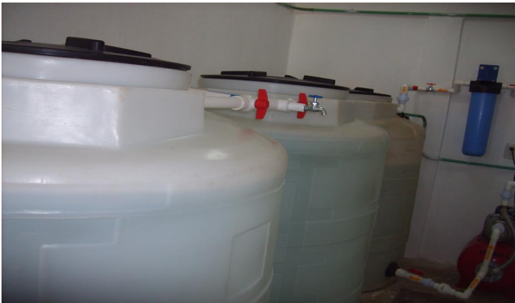
Foto 2-2 Área de almacenamiento de agua
