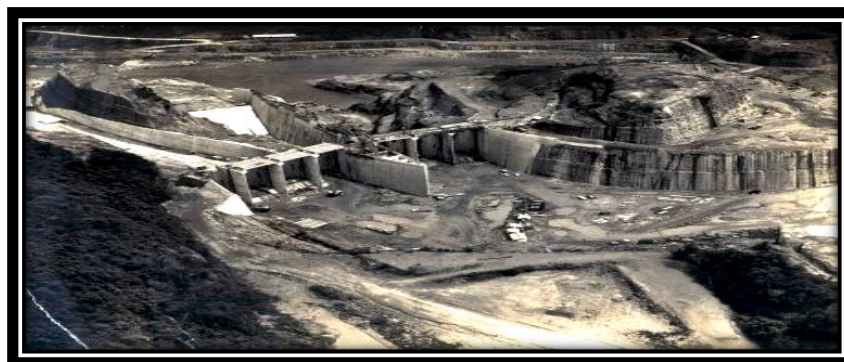
Imagen 2.1.1 Construcción de la Presa. (Fuente: proporcionado por C.F.E.)
