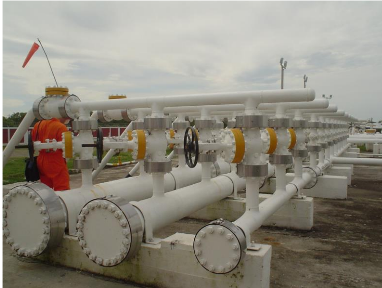
Figura 4.14 Cabezales de Alta Presión, Baja Presión y Cabezal de Prueba
