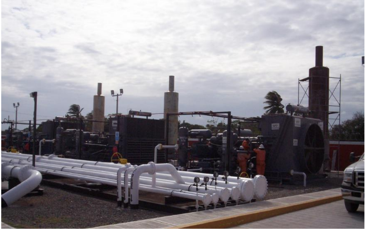
Cabezales de la Estación de Compresión de Gas
