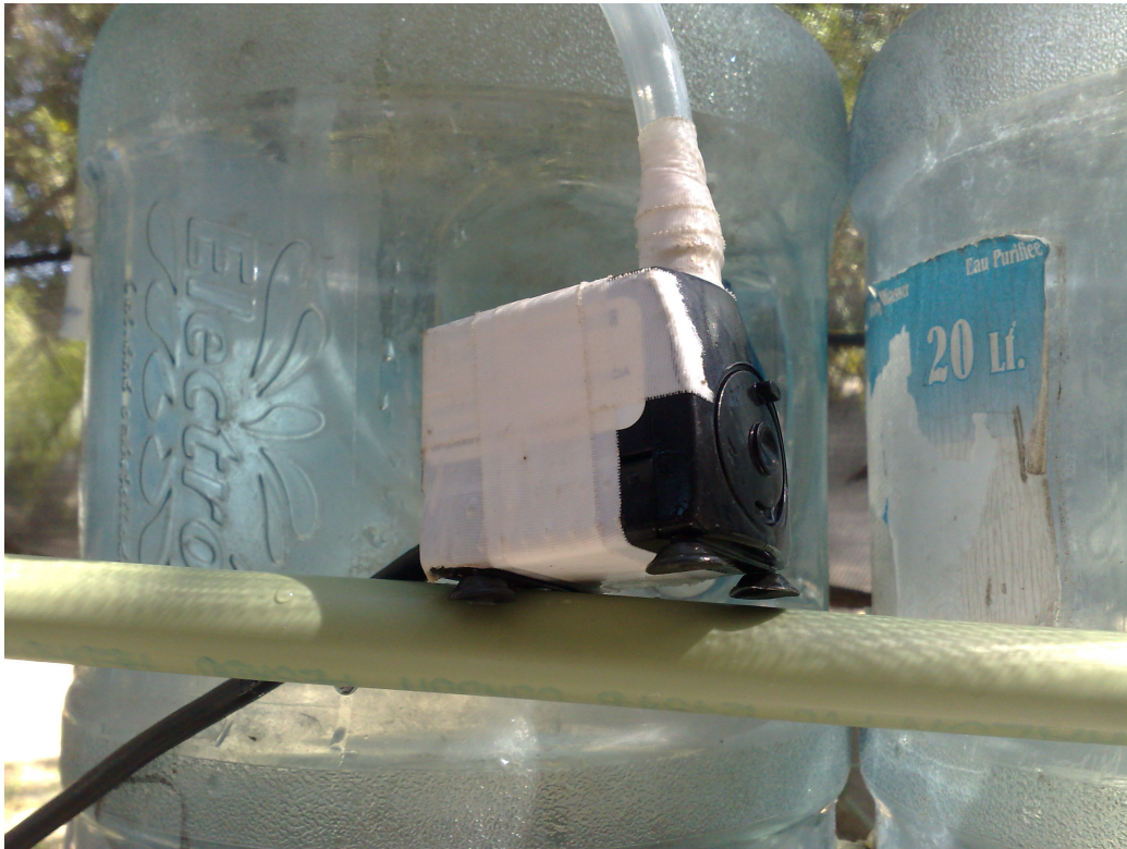
Figura 5.6: La bomba de riego
