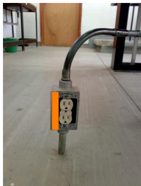
Figura 5-7 Ejemplo de señalización, color naranjado.
