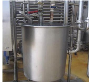
6.-.-Para drenar el agua de enjuague abrir la válvula de paso del tanque de 1000 lts.
