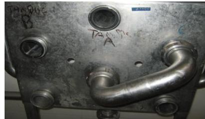
13- para esto se dirige hacia el 2º Manifiù Y se cambia la tubería de tal forma que la leche circule hacia el tanque "b".
