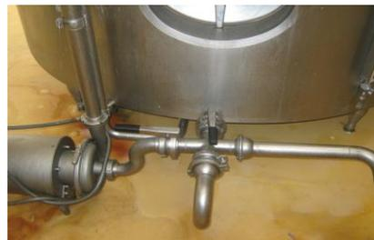
14- se abren y se cierra las válvulas correspondientes de tan forma que la leche circule del tanque de 8000 al tanque "b".
