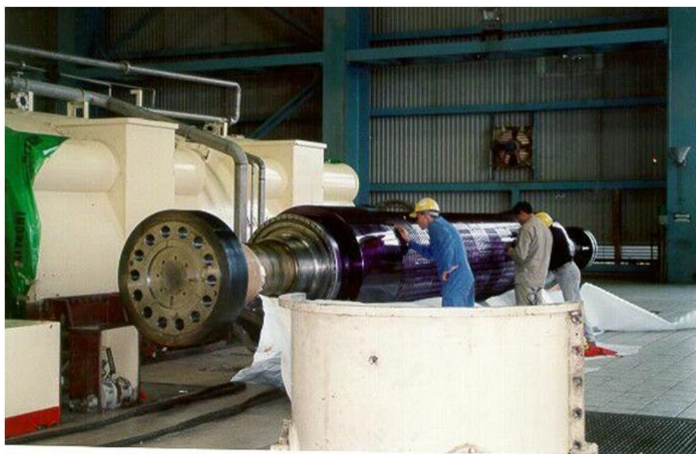
Figura 8. Inspección del rotor del Generador Eléctrico de la C T V.D.R.
