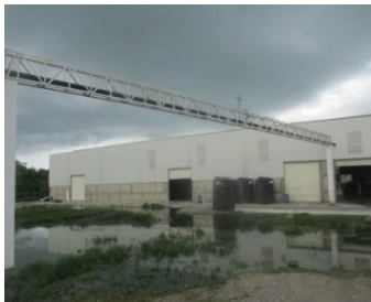
Imagen 2.7 instalaciones de la planta de harinas.
