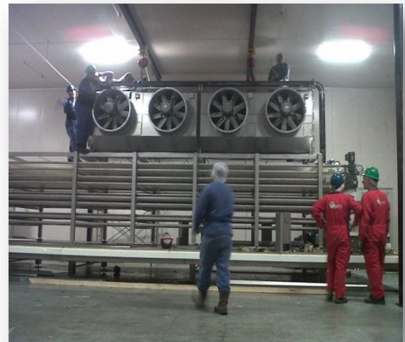
Imagen 6.5 Instalación del túnel de congelación del filete.
