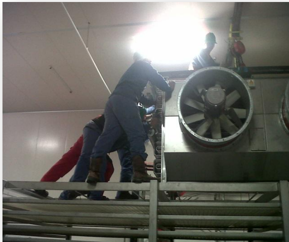
Imagen 6.4 Instalación del túnel de congelación del filete.
