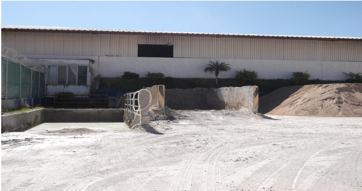
Figura 6.4.5 Fosa de lavado sin señalización, pequeña y en mal estado.
