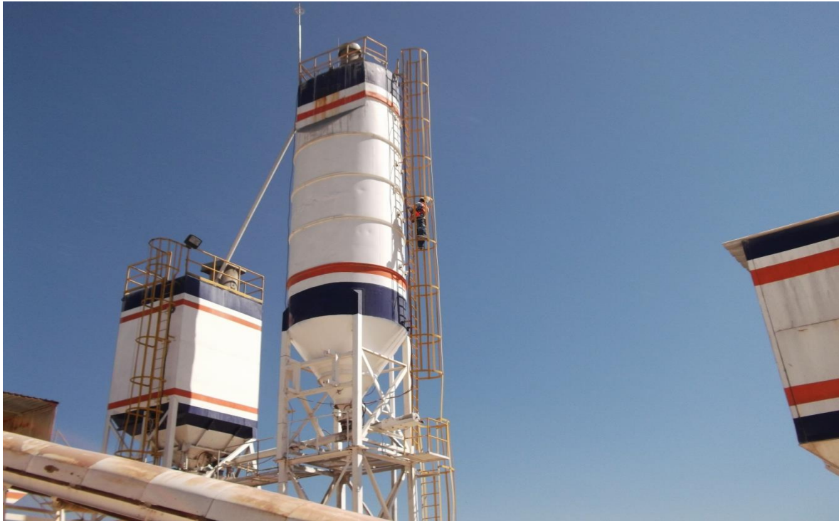
Figura 6.4.2 Personal sin EPP adecuado.
