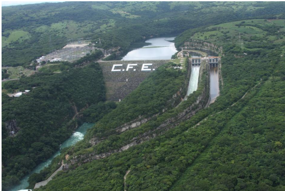
Fig.2.1 cortina de la Central Hidroeléctrica Belisario Domínguez
