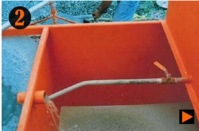
Fotografía 5.4. Mezcla del agua a tratar con el coagulante y floculante.
