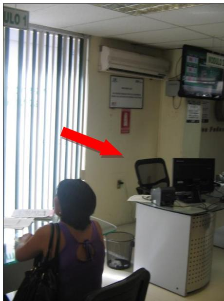
**Figura 5.3** Señalamiento sin extintor
