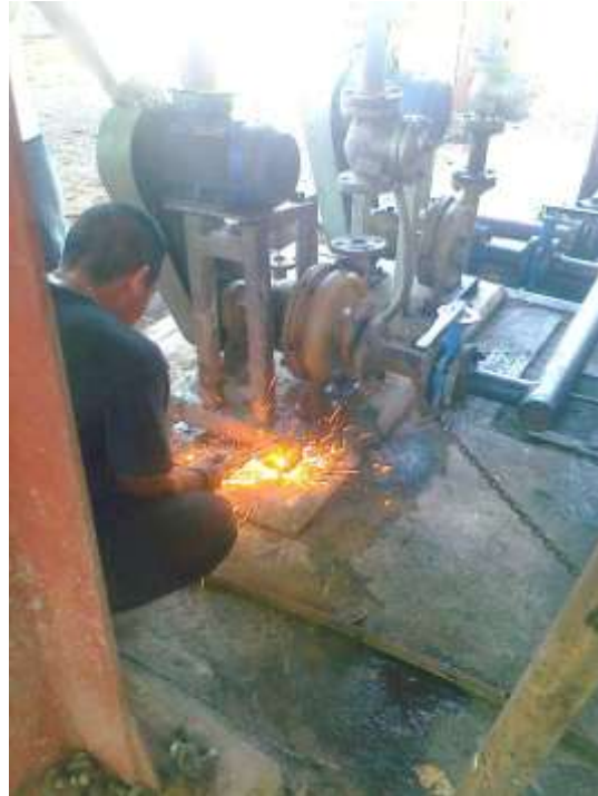
Figura 6.6 Aplicando soldadura en las bases de la bomba de recuperación de aceite
