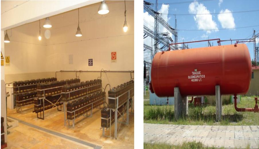
Figura 3.2.2. Cuarto de batería y bomba hidroneumático
