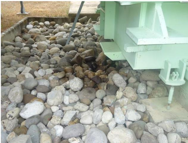
**Imagen 5.4.1** Contaminación de suelo en el Transformadores del área de 400 Kv.
