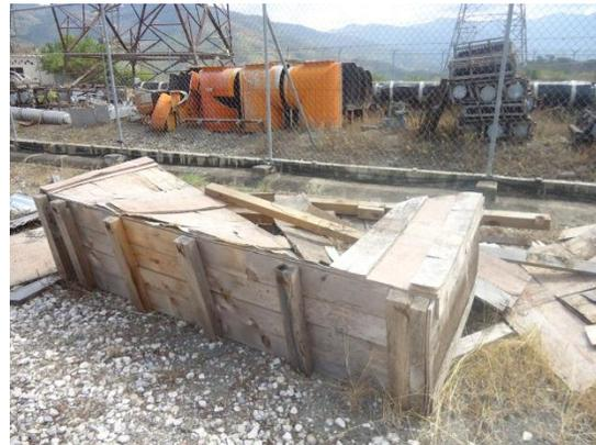
**Imagen 5.7.6.4** Acumulación de madera y sin almacenamiento adecuado, en el área de 115 Kv de la Subestación
