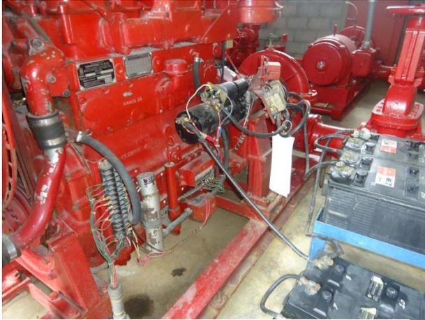
Sistema de accionamiento de la maquina: presencia de fuga de aceite, baterías con presencia de sustancia electrolítica, tarjeta de mantenimiento obsoleta, cables a la intemperie. Se genera contaminación al suelo y se expone la seguridad y salud del trabajador.
