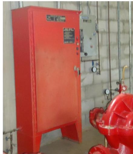
**Figura 5.8.1.3** Equipo de planta de emergencia sin señalamiento
