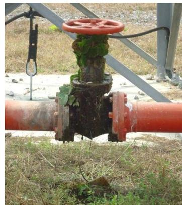
**Imagen 5.2.2.2** Fuga de tubería en el área de 400 Kv.
