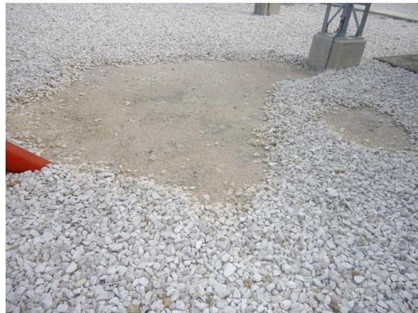
**Imagen 5.4.2** Cambio de grava contaminada del área de 400 Kv.
