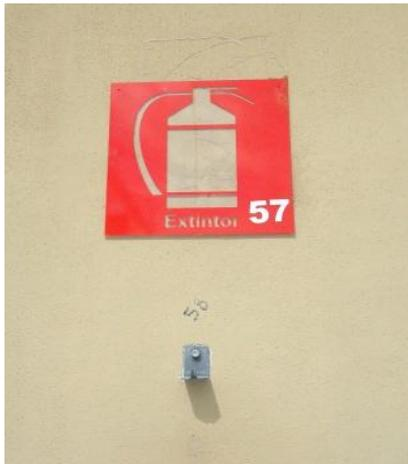
**Imagen. 5.6.3.1** Señalamiento inadecuado de extintores
