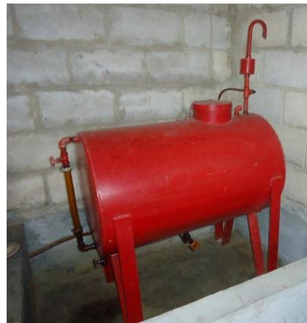
**Figura 5.8.1.1** Equipo de planta de emergencia sin señalamiento
