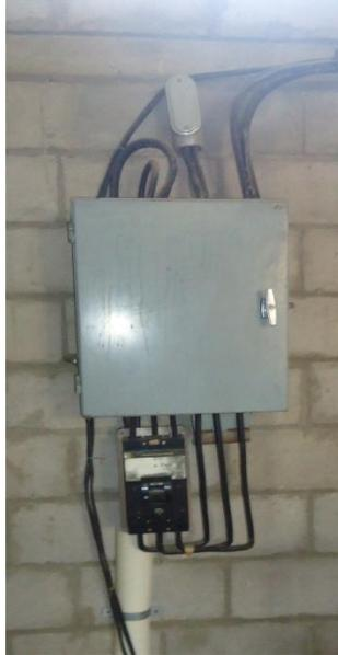
**Figura 5.8.1.2** Equipo de planta de emergencia sin señalamiento
