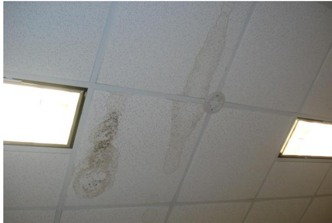
**Imagen 5.7.5.1** Techo húmedo del área de Seguridad e Higiene
