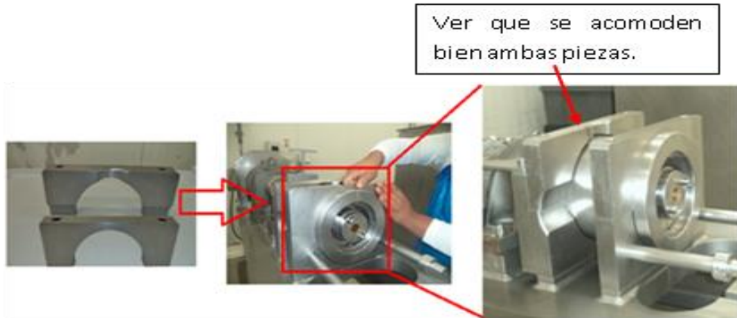
Figura 12.- Colocación de la pieza 8 y 9.
