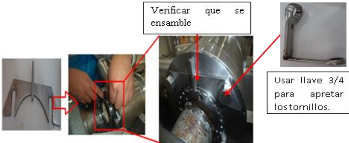
Figura 10.- Colocación de la pieza 6.
