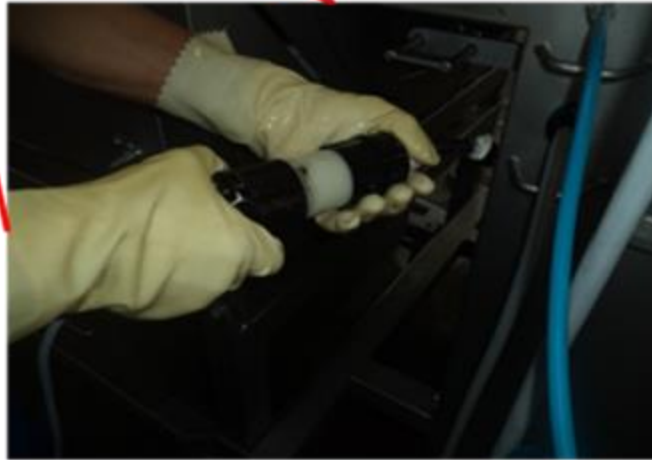
Figura 3: ensamble de cable para corriente eléctrica.
