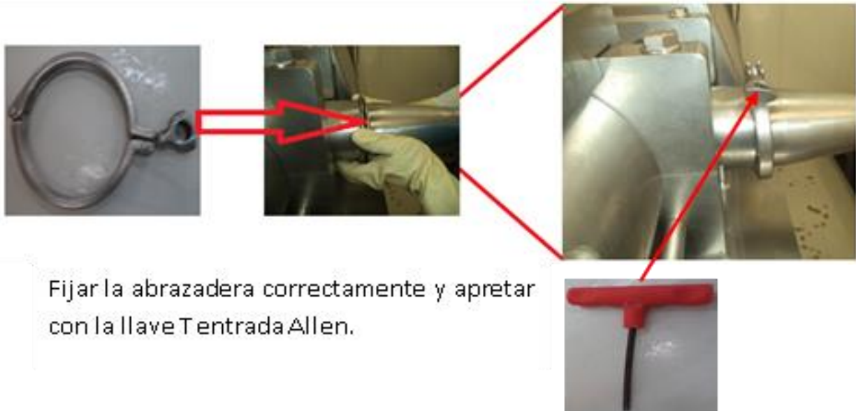
Figura 5: Colocación de la abrazadera.
