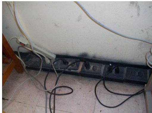
Fotografía 4.4, mal cableado.
