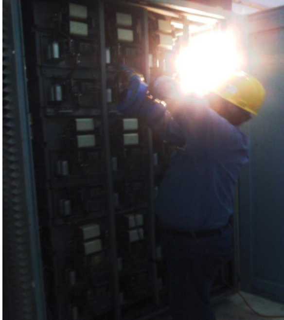
FIGURA 4.3 LIMPIEZA AL BANCO DE THYRISTORES
