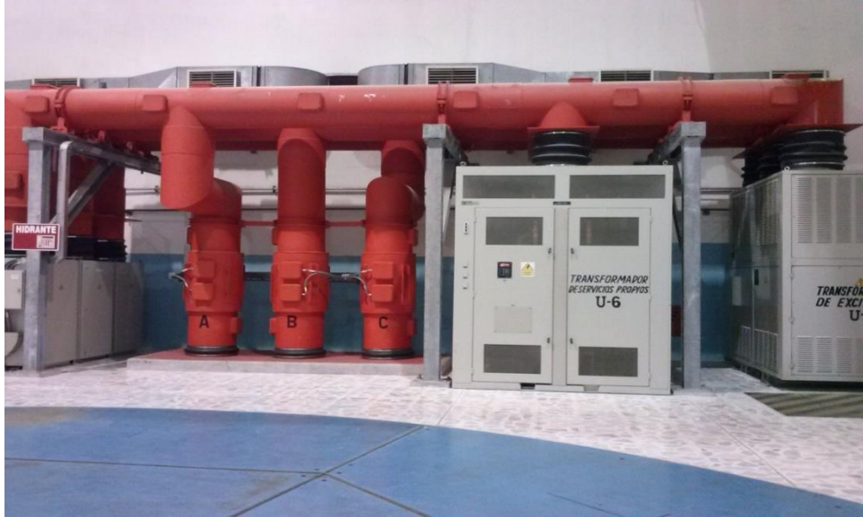
Figura 4.6 Restablecimiento de Energía Eléctrica al Banco de Thyristores
