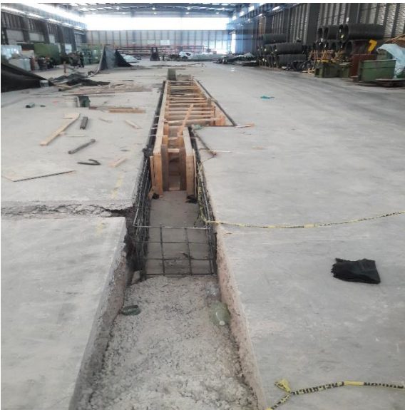
Imágenes de los avances de la obra civil de la instalación de la nueva línea.
