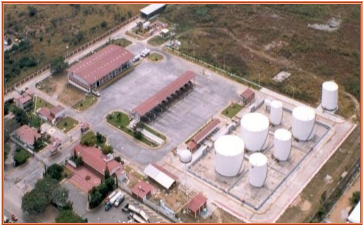
Figura 2.1. Localización topográfica de Pemex Refinación (Fuente: Pemex refinación 2012)
