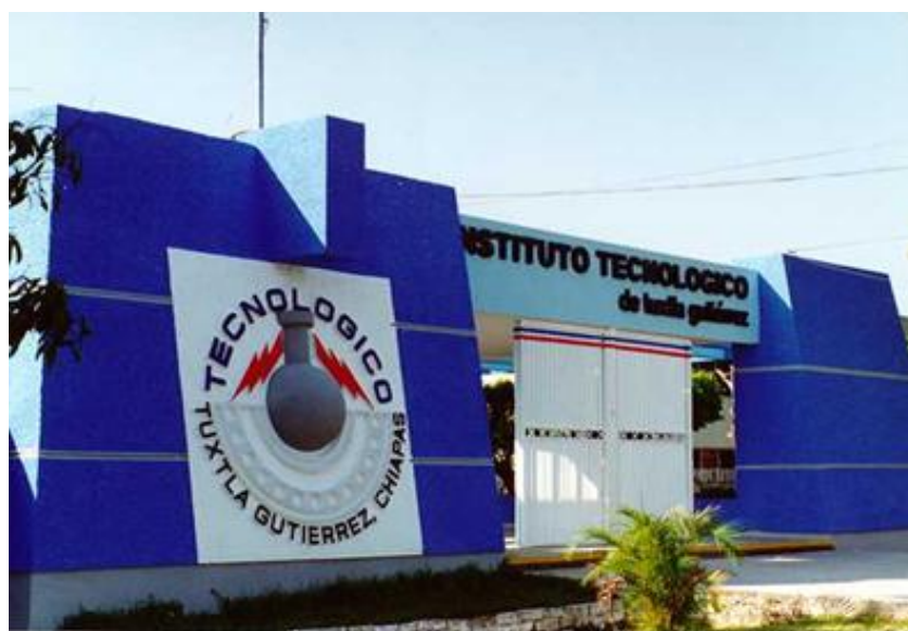
Figura 2. Entrada principal del ITTG.
