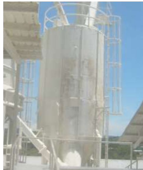
Figura 5.1. Silo 3 de almacenamiento.
