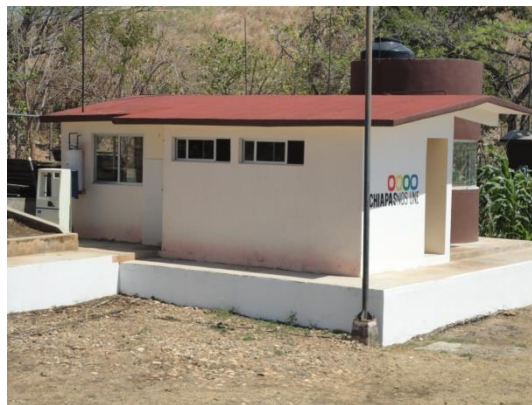
Figura 4.1 Oficinas y baños
