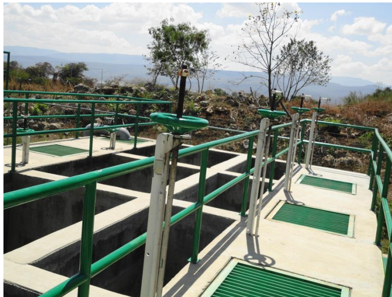
Figura 2.5 tanque de filtros de material graduados
