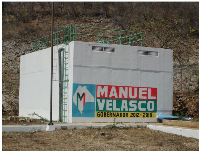
Figura 4.6 Tanque de almacenamiento
