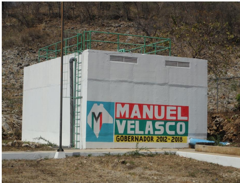
Figura 2.7 Tanque de almacenamiento de agua potabilizada
