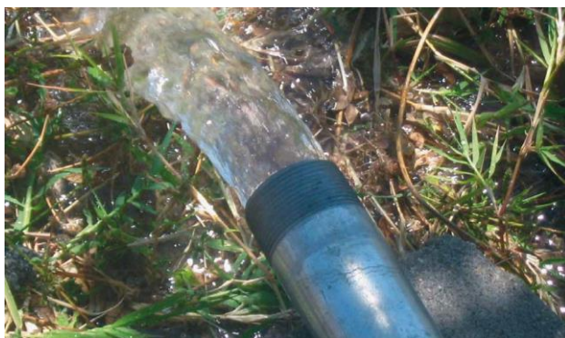
FIGURA No.16. Caudal de descarga de la planta de tratamiento del Aeropuerto “Ángel Albino Corzo”. FUENTE: SEMAVIHN.
